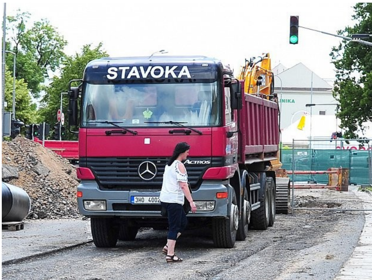
Vozovka v Palackého třídě před DDM Chrudim
