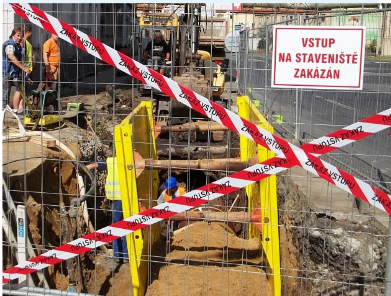
Oprava kanalizace. Ilustrační foto.
